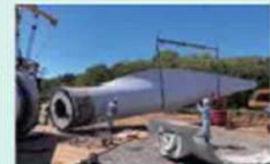
例：風力発電のブレードの解体
