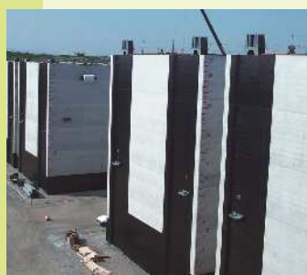
内護岸に使われる巨大な鉄筋コンクリートブロック (ハイブリッドケーソン)
